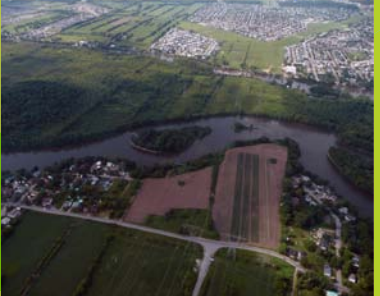
Vue des lignes électriques
